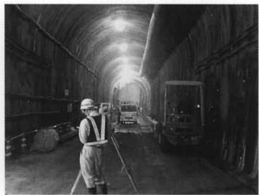
図一12 トンネル工事現場入口部ならびに計測状況 上：トンネル入口部 下：トンネル内
