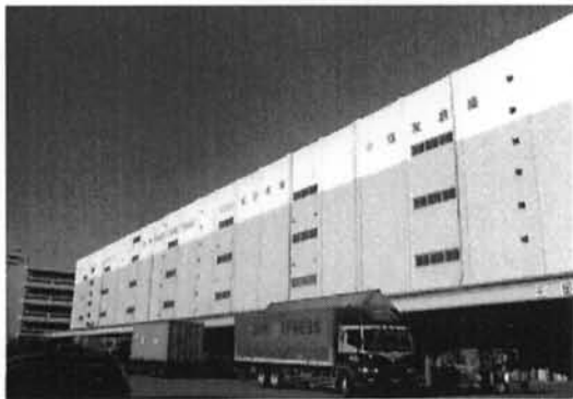
写真-1 解体前の状況
