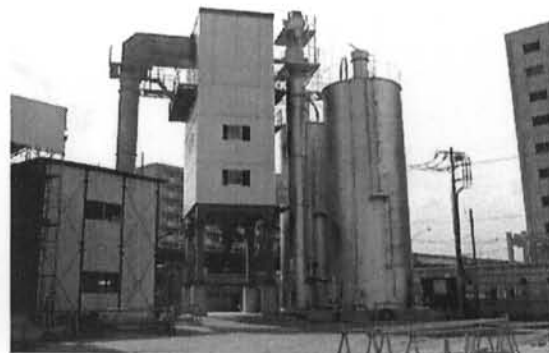
写真-4 生コンプラント
