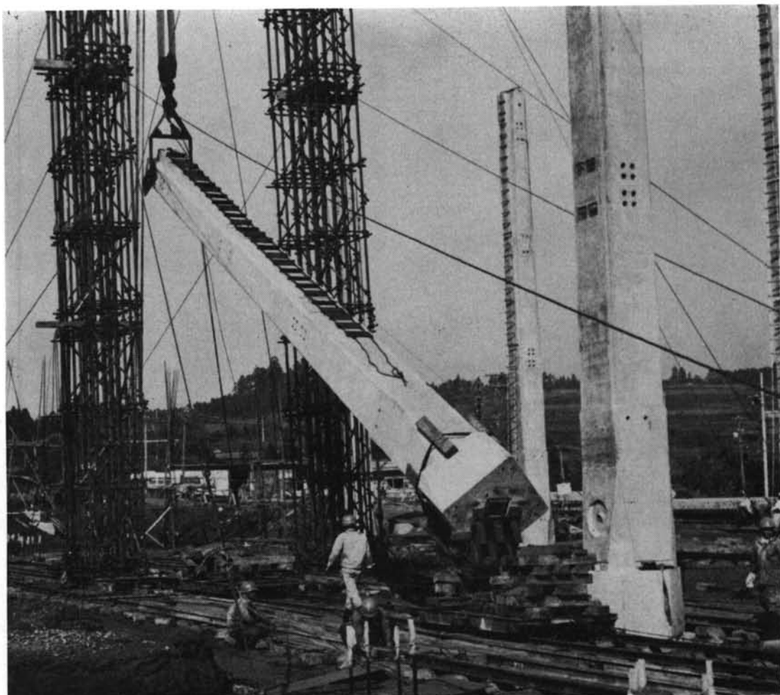
写真-6 Aスラブ用柱の建方
