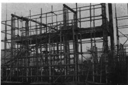
写真-19 Bスラブ1枚目のリフトアップ
