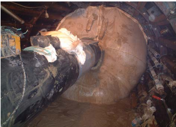
写真 - 8 トンネル仕切用モルタルパック
