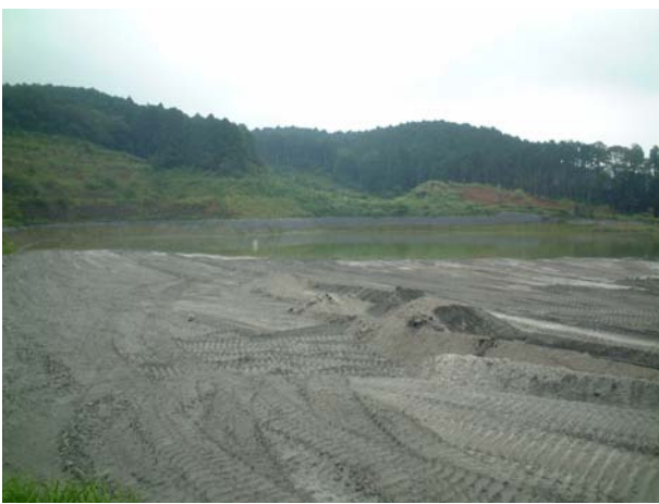
写真 - 3 PS 灰の最終処分場
