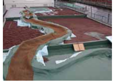
写真 - 6 排水層・水辺まわりの施工
