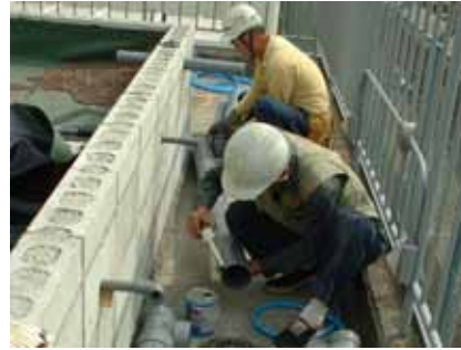
写真 - 5 給排水管の施工
