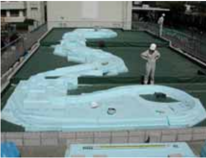
写真 - 4 遮水・耐根シート、造形部の施工
