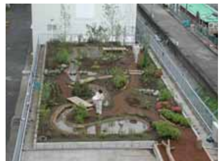
写真 - 9 竣工直後
