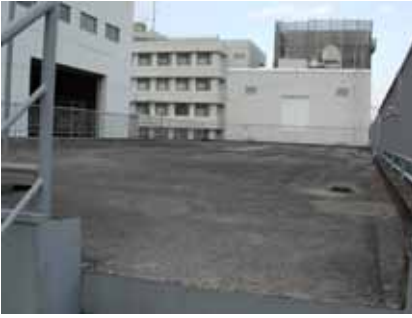
写真 - 1 設置場所の整地
