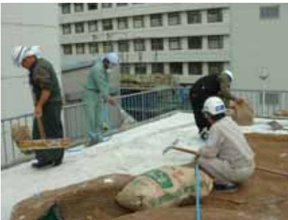
写真 - 7 人工軽量土壌の施工
