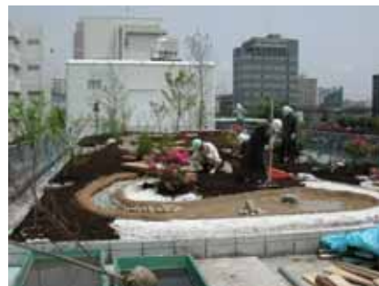
写真 - 8 畑土・植栽施工
