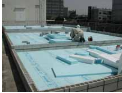
写真 - 2 見切材・嵩上げ材の施工
