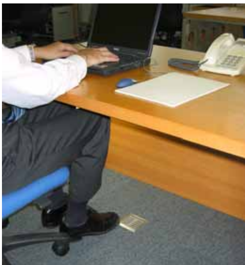
写真 - 2 パーソナル吹き出し口設置状況
