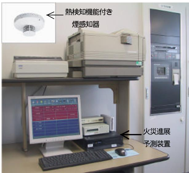
写真 - 4 主な構成機器と熱検知機
