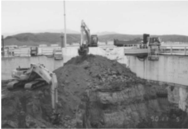
写真 - 2 再掘削中の人工島
