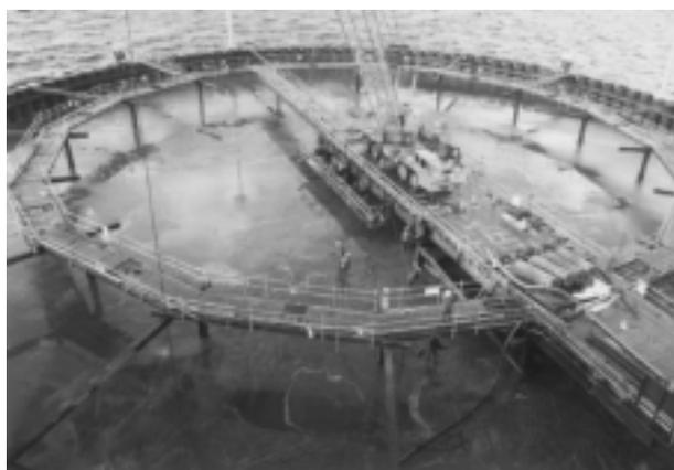
写真 - 1 石炭灰スラリー打設中の人工島
