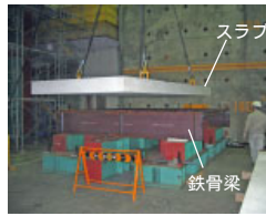
(b) スラブ設置
