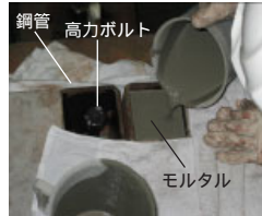
(c) モルタル打設
