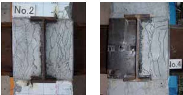
<No.2> (直交梁断面：正面) <No.4・ふさぎ板側> (片側のふさぎ板のみを切除)
