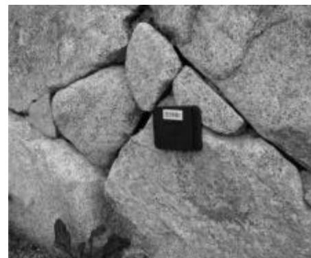
図 - 1 RFID タグ (設置例)
