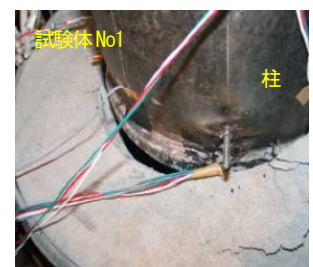
写真-7 柱とコンクリートの離間
