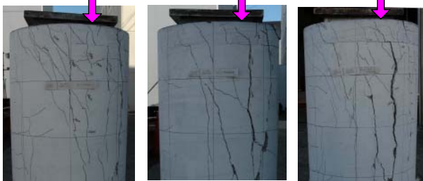
写真-1 最終破壊状況 (No. I, No. III, No. IV)
