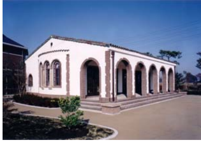
写真－4 清風亭外観
