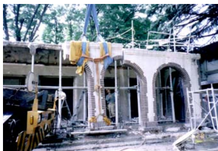
写真-6 外壁アーチ解体状況
