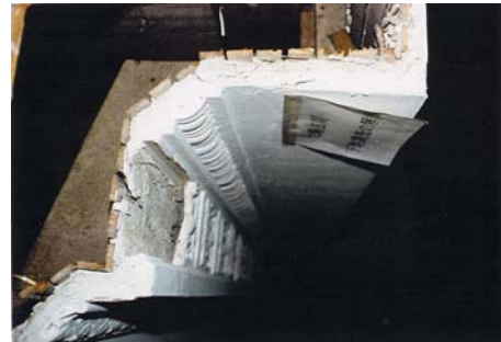
写真-12 漆喰仕上断面
