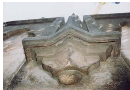
写真-13 安山岩外壁
