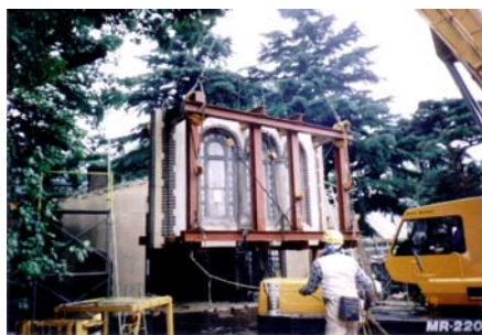
写真-7 出窓壁解体状況
