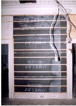
写真-10 合板補強
