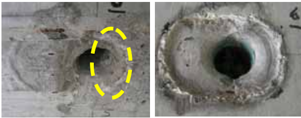
(a) 試験体 T25-0.4 (b) 試験体 T25-0.7 写真 - 3 拡径部近傍コンクリート状況
