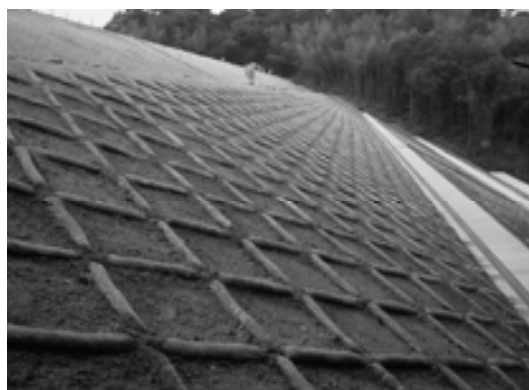
写真-1 エコ法枠施工法面
