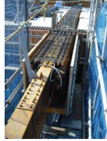
⑦型枠セット
