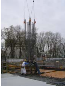
写真-3 柱先組鉄筋の建込状況
