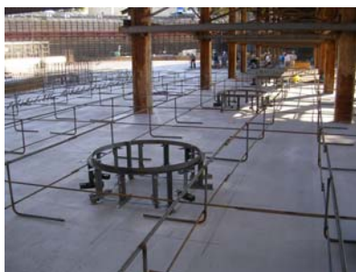
写真-8 免震装置縦補強筋取付架台
