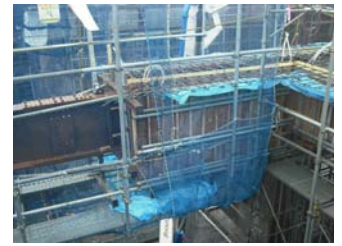
⑧コンクリート打継部処理 グラウトホース養生
