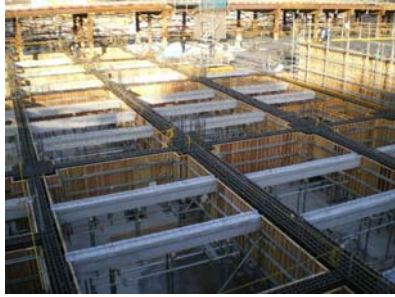
写真-6 サイト PCa 小梁の架設状況
