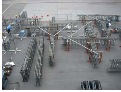
写真-4 梁先組鉄筋の配筋状況
