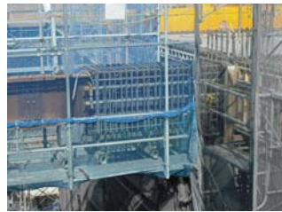
⑥PC 鋼棒セット あばら筋等配筋
