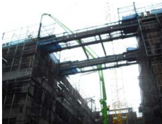
⑨コンクリート打設
