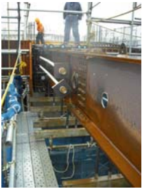
⑤梁先組鉄筋 鉄骨梁セット
