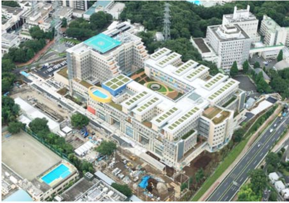
写真-1 竣工状況
