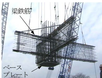
写真-9 上部ベースプレートと梁鉄筋の一体化
