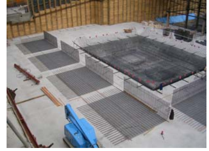
写真-5 壁先組鉄筋の配筋状況
