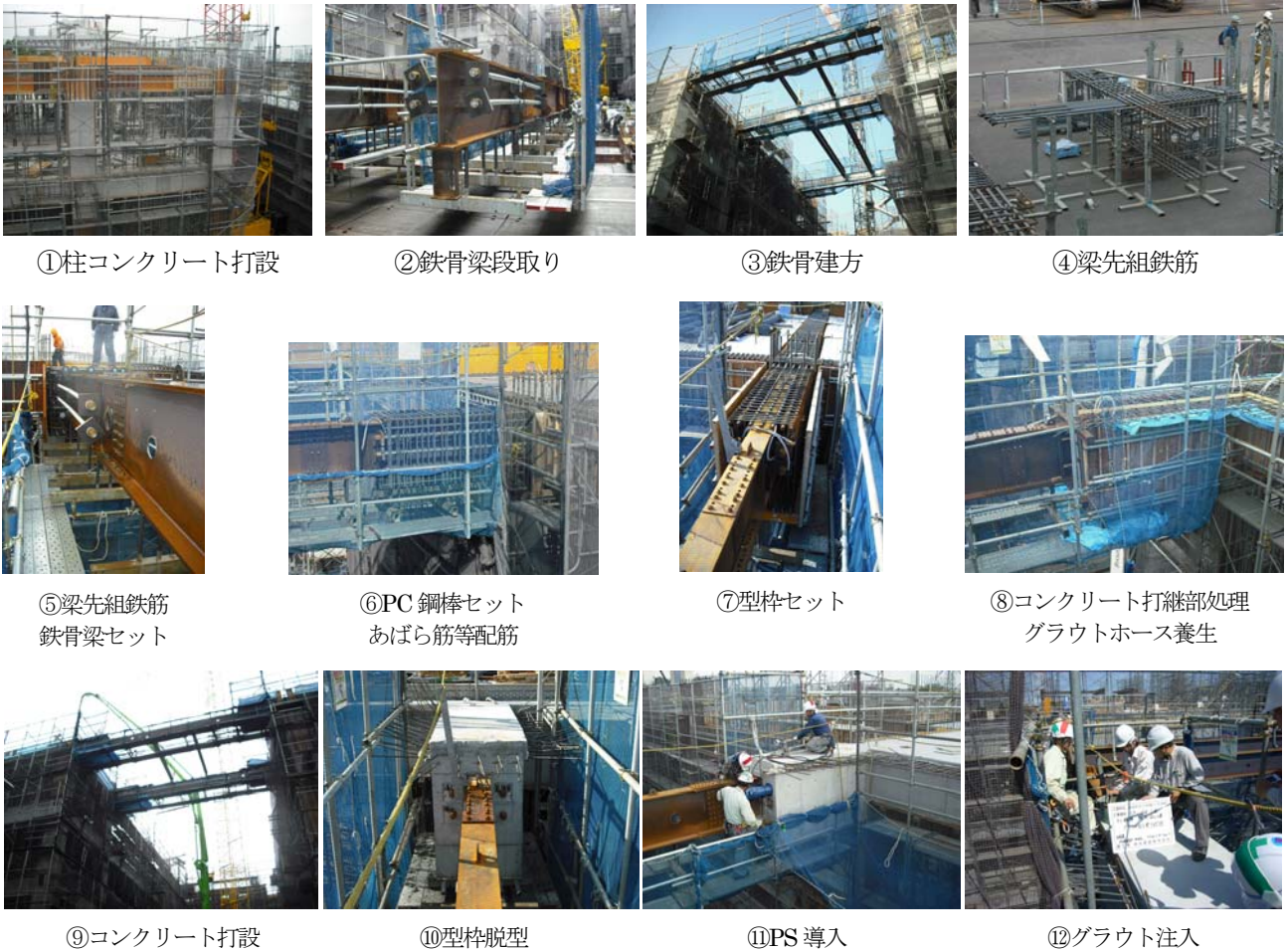
写真-7 PS Hy-ECOS 構法の施工手順
