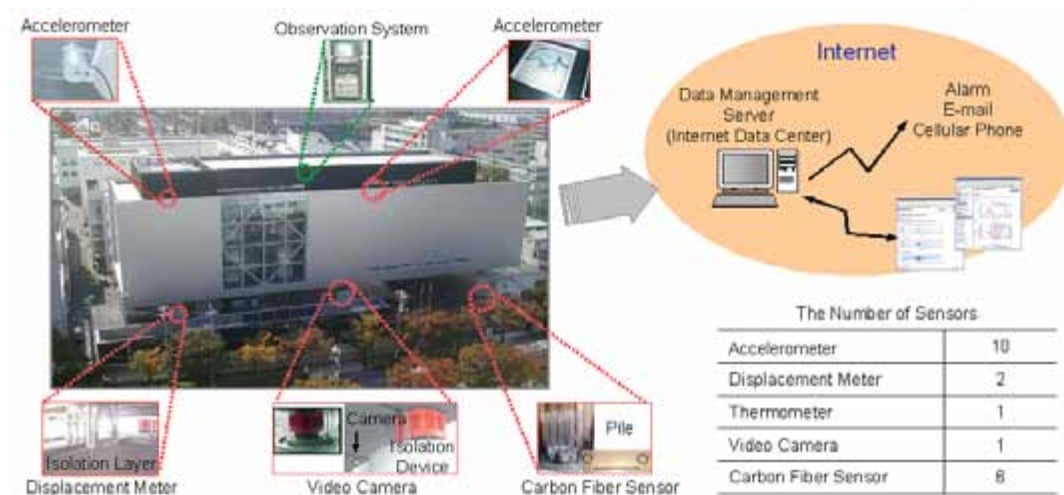
図-1 対象建物と構造ヘルスマニタリングシステムの概要
