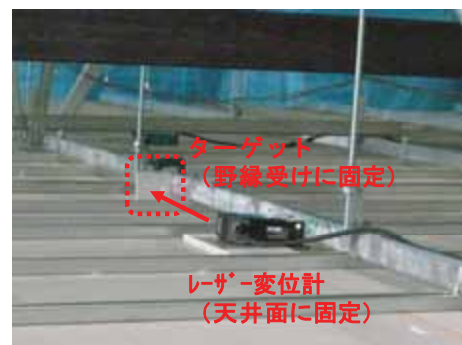
写真-2 天井面と野縁受けとの相対変位測定
