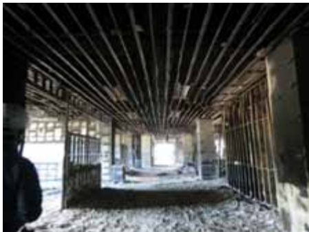
写真-15 3階ホールから南側廊下
