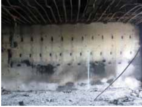
写真-13 3階6-2教室東側壁面
