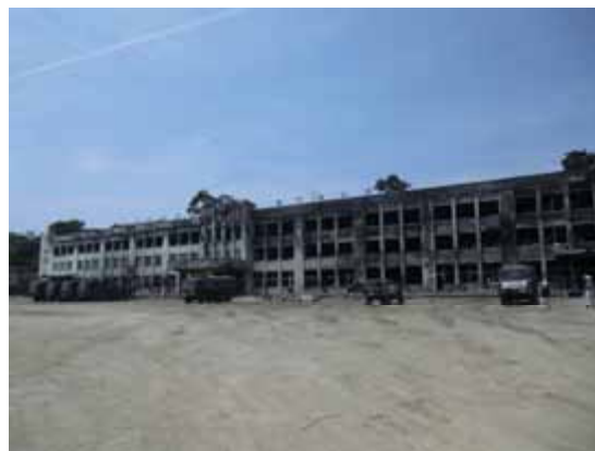
写真-1 震災後の状況(2011年6月7日撮影)
