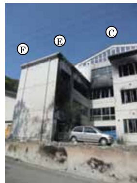
写真-9 西側外壁面 C通～F通間
