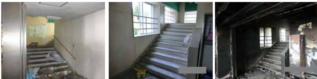
写真－3 中央階段の状況(左写真：1階、中央写真：2階、右写真：3階)
