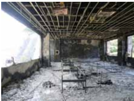
写真-16 3階図書室西側(左が南面)
