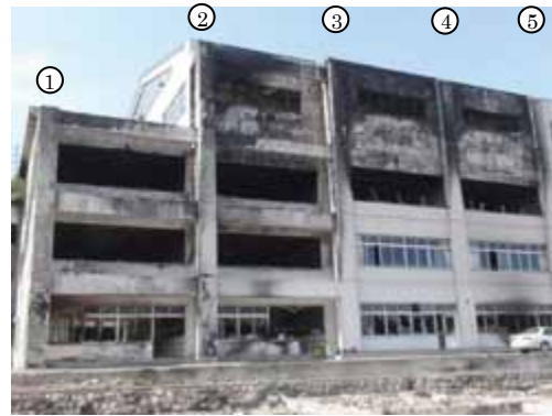
写真-8 南側外壁1通～5通間
