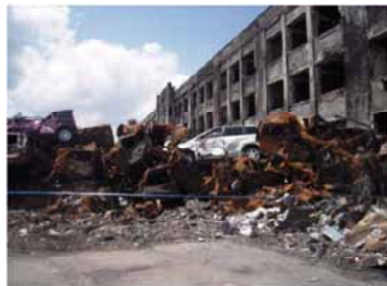
写真-2 燃焼した自動車等の瓦礫 7)
