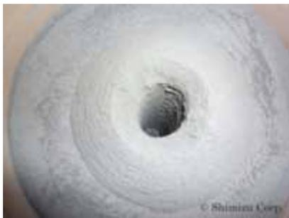
写真-7 掘削後のボアホール(深さ約40cm)
