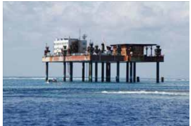
写真-5 沖ノ鳥島の作業基地(SEP)
