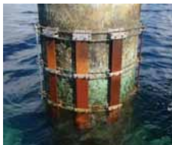
写真-9 飛沫帯暴露実験(沖ノ鳥島、着底式)
