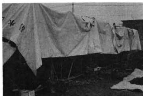
写真-1 コンクリート版のシート囲い
