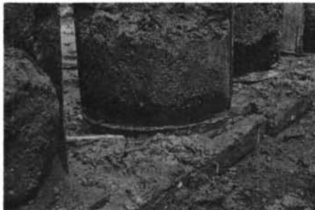
写真—12 打設されたコンクリート塊（直径1mの実験ソウに細砂を50cm入れた実験）
