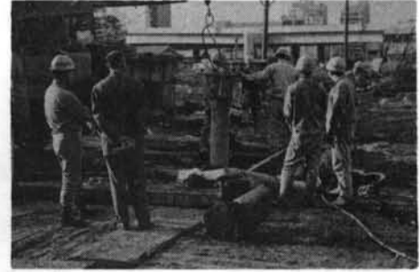
写真-9 特殊トレミー管をソウ入し砂上端に到達
