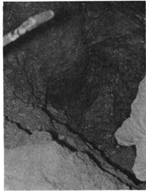
写真-3 在来工法によるクイの先端(黒い土が沈殿土砂)
