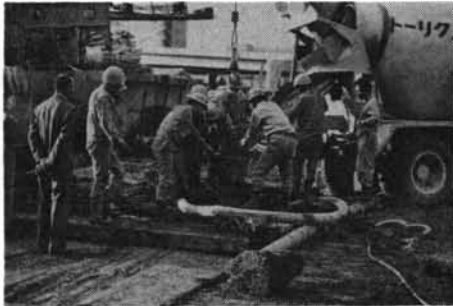
写真—10 コンクリートの投入（ジェットすると2～5分で実験ソウ底に到達する。コンクリートの投入中もジェットは続けている。）
