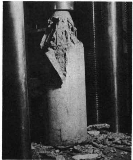
写真-2 R・C 300-2 破壊状況
