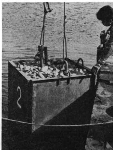
写真一七 クレーンで型わくを吊り下ろす
