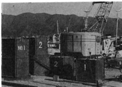
写真—6 鋼製型わく
