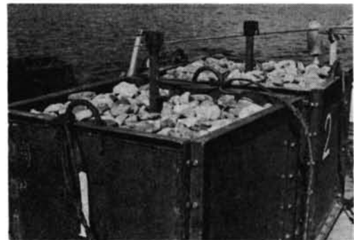
写真一 1 型わくに詰められた粗骨材
