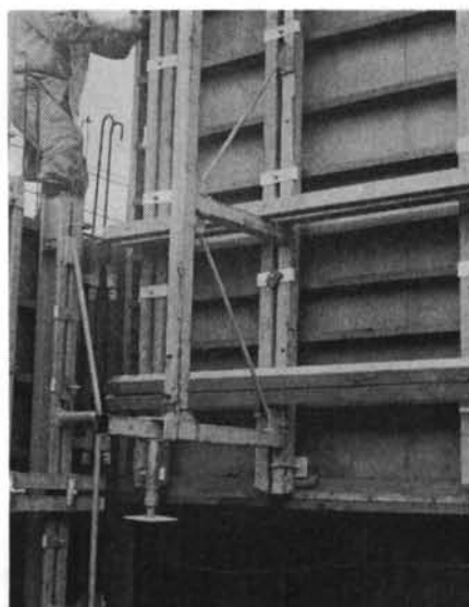
写真-5 内側パネルの吊込み
