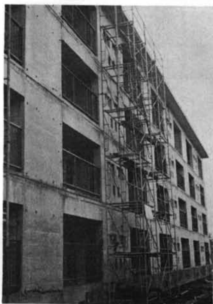
写真-28 ローリングタワー。レールの上にのせてある
