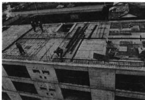
写真-17 流れ作業の進行状況を示す。左からコンクリート打ち完了、配筋、型わく作業
