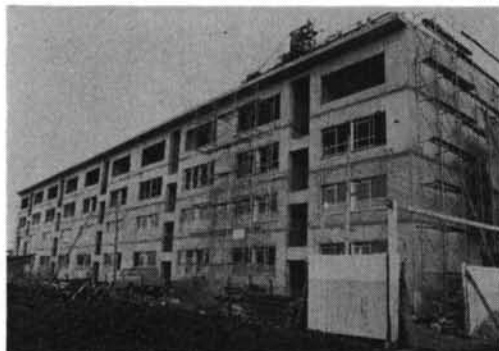
写真-32 仕上げ工事に入った豊田アパート現場
