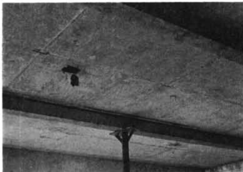
写真-14 せき板を取りはずした状態。存置根太とサポートには全く手を触れていない。このまま4W程度の養生をする。
