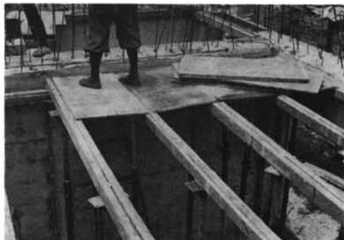
写真-11 スラブせき板の取付け。根太は1本おきに取りはずすものと存置するもの。
