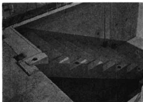
写真-23 階段のプレキャストを吊込んだ状況
