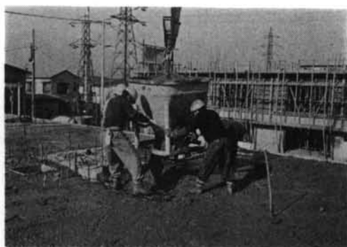
写真-16 スラブのコンクリート打設
