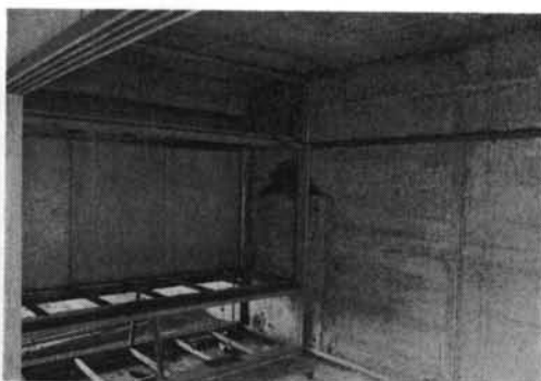
写真-29 コンクリート面にわくを取付ける
