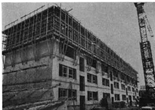
写真一 清水F式工法によって建設中の豊田アパート
