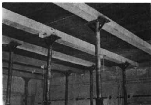
写真-12 スラブ型わくの組立て完了。取外し根太と取付金物の状況
