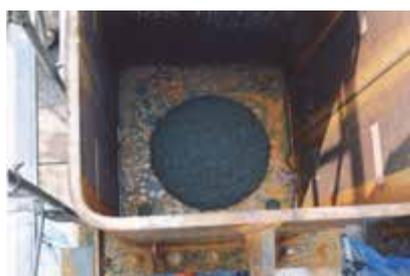
写真-1 CFT ダイヤフラム部開口部の充填状況
