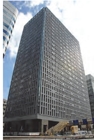
写真-1 対象建物外観
