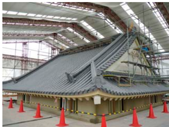
図 - 1 駿府城公園 坤櫓復元工事
