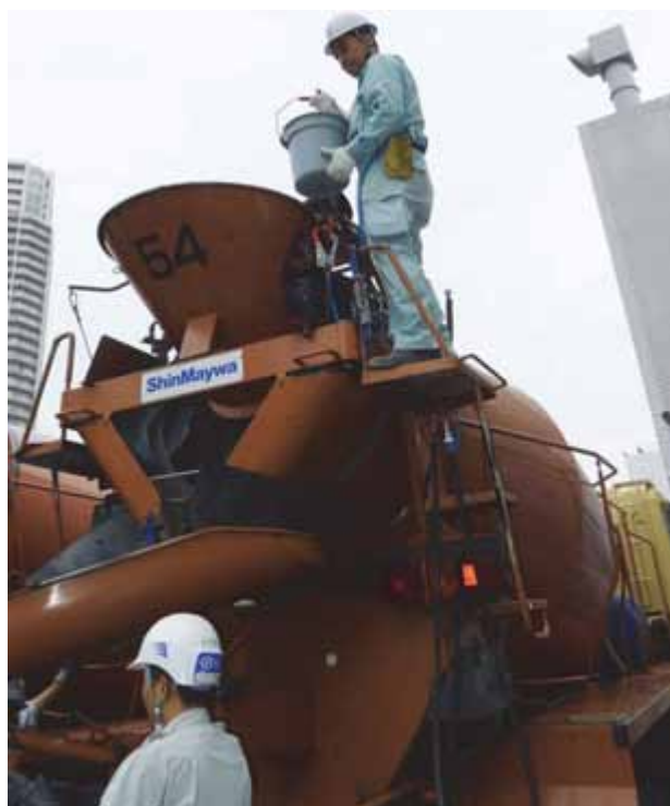
写真-1 スラリーの投入の様子
