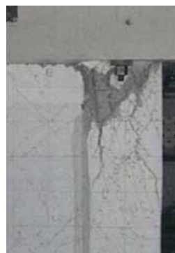
RC造耐震壁増設補強
