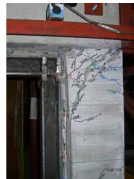
枠付き鉄骨ブレース補強
