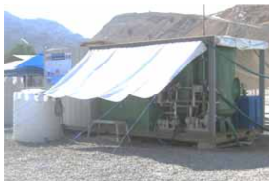
図 - 2 The PP Installed on a Actual Site
