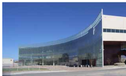
建物外観(北面)
