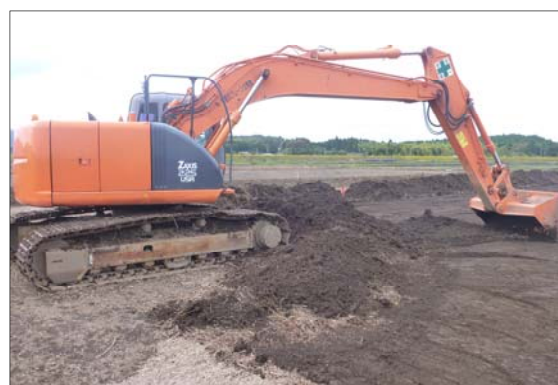
写真-4 表土剥ぎ取りによる除去土壌の発生状況
