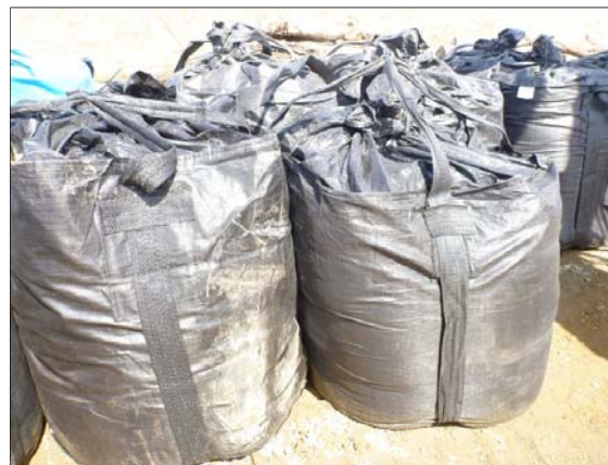
写真-1 除去土壌等を詰めた大型土のう袋
