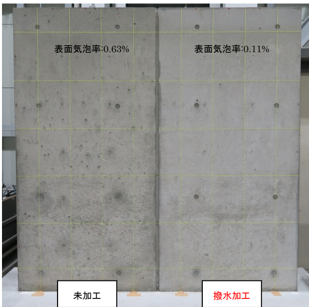
写真-20 脱型後のモックアップ外観
