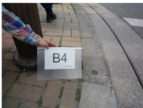
写真-2 測点 B4: 歩道の金属釘
