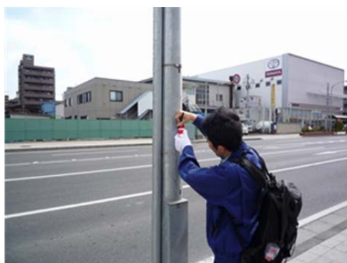
写真-4 中継点の設置
