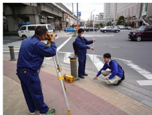
写真-5 測点のレベル計測
