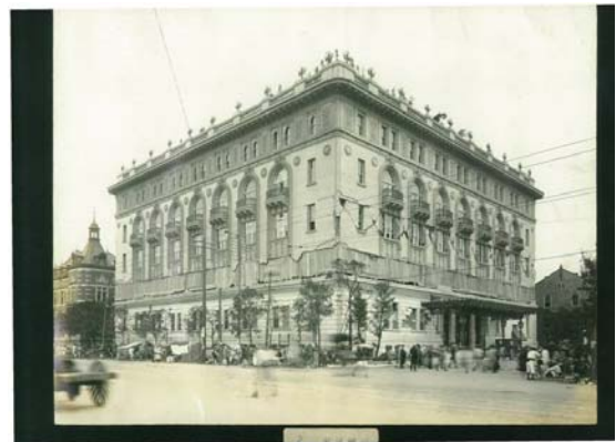
写真-4 東京会館被害 (外部)
