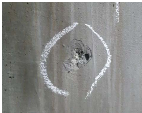
写真-6 熔融スラグ骨材（生石灰）によるポップアウト
