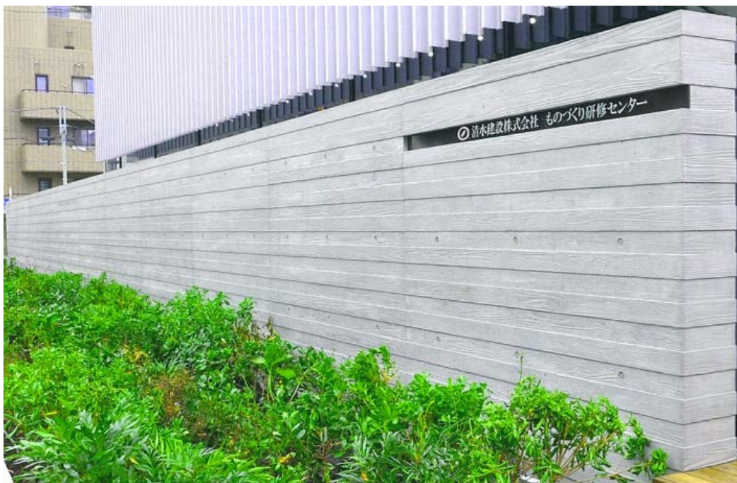
写真-13 アートコンクリートの実構造物への適用状況
