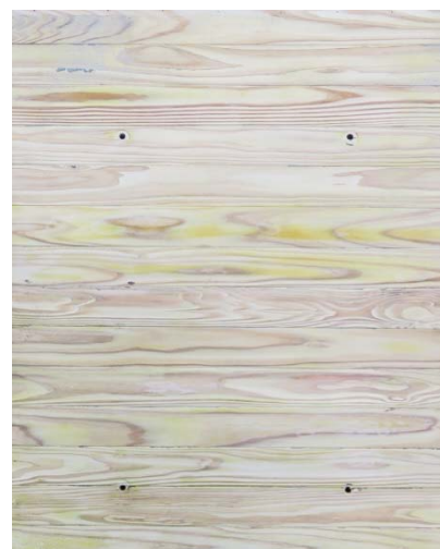
超撥水処理を行った 使用後の型枠（アート型枠）
