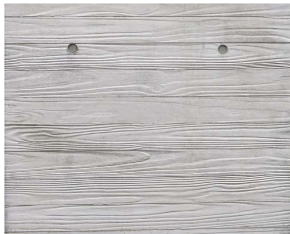
超撥水処理による方法（アート型枠）
