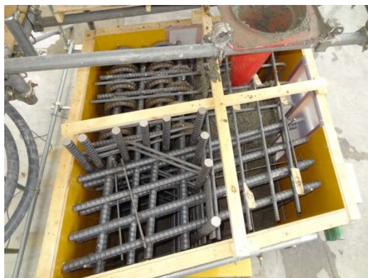
写真-7 地中梁接合部の1/4部分の模擬型枠
