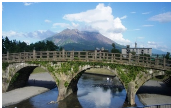
写真-6 地盤免震を採用した石橋
