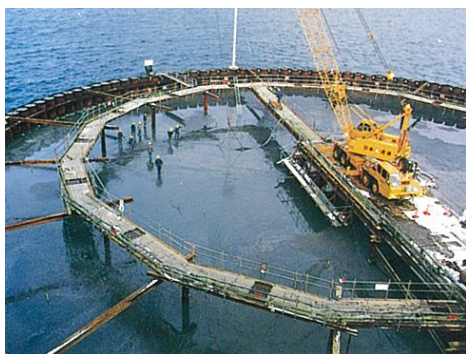
写真-9 石炭灰による埋め立て
