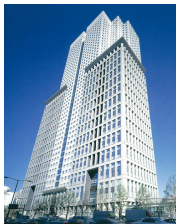
写真-3 施工時解析を行った代表的な高層ビル
