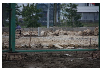
写真-7 敷き均したライムストーン
