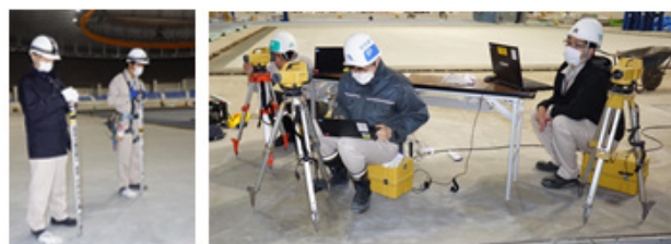
写真-8 デジタルレベルによる測定状況
