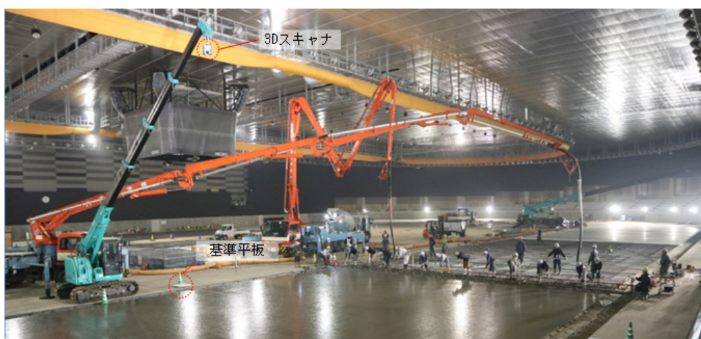
写真-3 3D レーザースキャナによる測定状況
