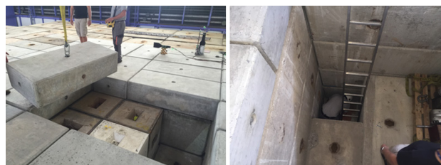
図-10 CHARM 遮蔽上部における放射化検出器の設置に伴うコンクリートブロックの一時除去
