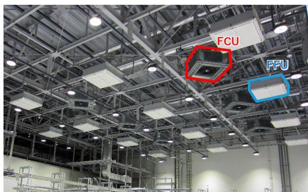
写真-1 アンビエントクリーン空調適用例
