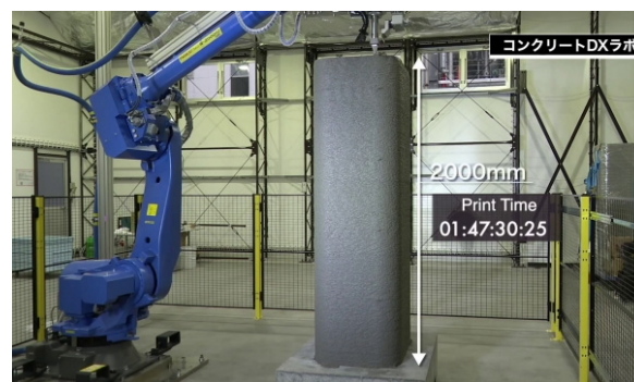
写真-2 高さ2mの3Dプリンティング状況
