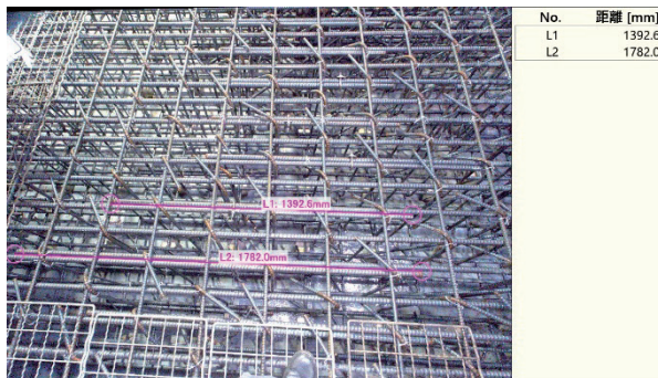
写真-9 重ね継手長計測の表示例
