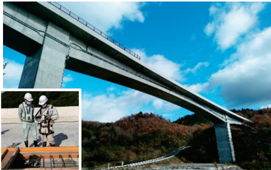
写真-14 検査状況(東根川橋上部工工事)
