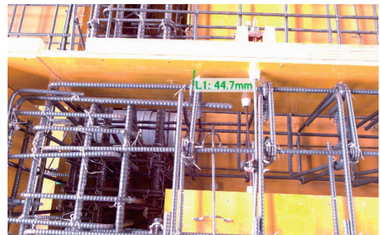
写真-10 かぶり計測の表示例
