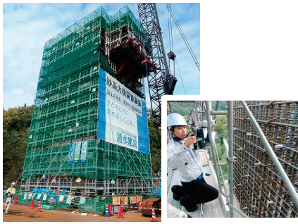
写真-13 検査状況(妙高大橋下部工工事)
